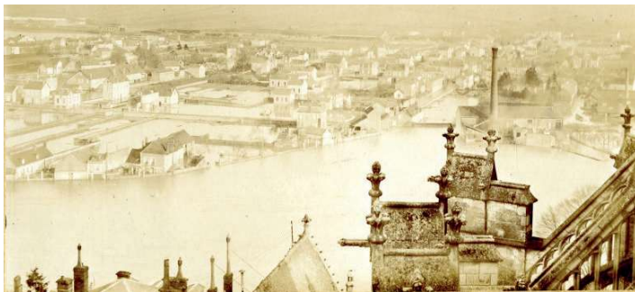
Vues de la crue de l'Yonne depuis la cathédrale d'Auxerre. 1910. ©Arch. dép. Yonne, 24 Fi 2
