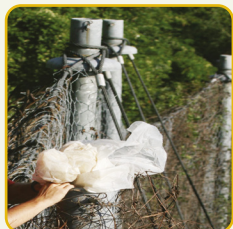
Poteaux des filets anti- dispersion des déchets
