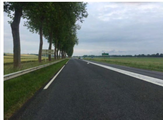
RD606 à hauteur de Villemanuche
