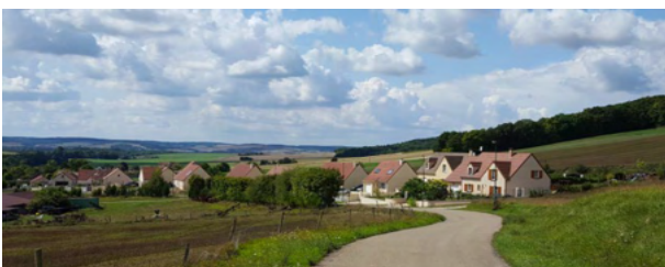
Opération en extension en rupture avec le tissu du village et au fort impact paysager à la Chapelle sur Oreuse
