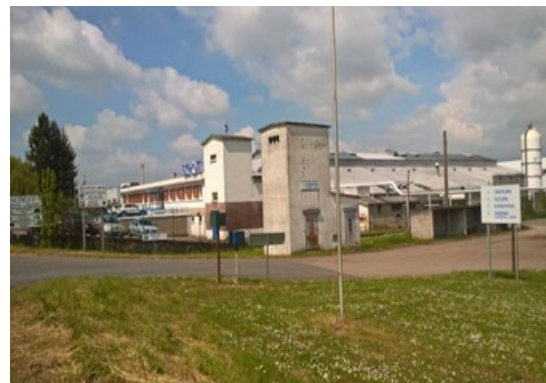
Schott France à Pont sur Yonne
