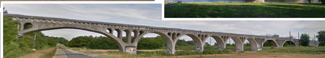
3) Pont-aqueduc entre Gisy-les-Nobles et Villeperrot
