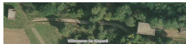
11) Siphon à Villeneuve-la-Guyard
