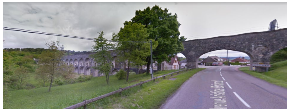
Entrée de ville le long de la D82 : vue sur l'Aqueduc de la Vanne
