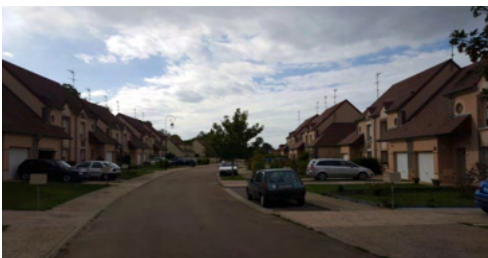
Une opération d'ensemble d'habitat individuel en bande structurant le paysage de la rue à Villeneuve la Guyard
