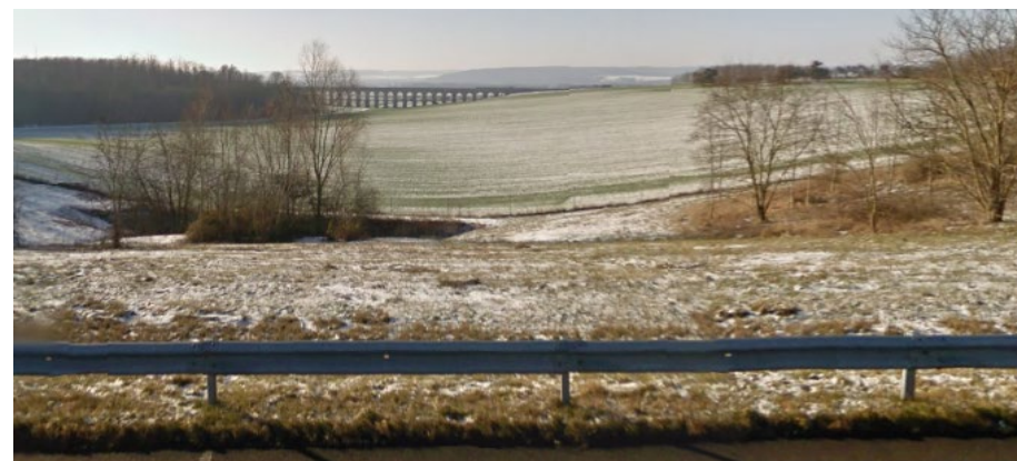
Vue sur le Pont-aqueduc de Cuy depuis l'A5
